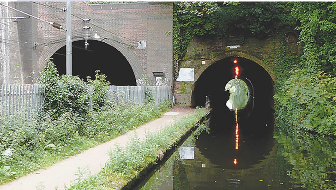
Edgbaston tunnels Photo: Roger Kidd via Wikimedia Commons
